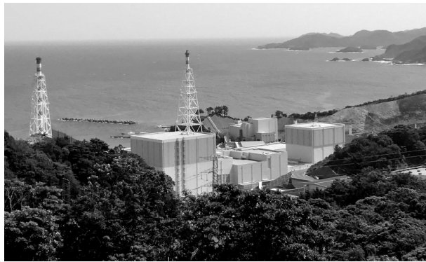
島根原発 手前の建屋が2号機、その右が1号機
